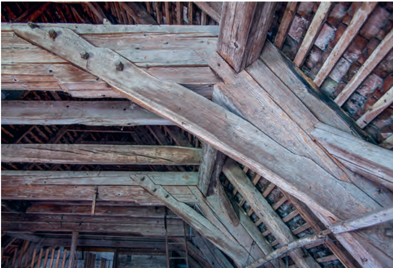
ABB. 126 Klingnau. Unterstadtgasse 10. Bohler-Haus. Detail der Dachkonstruktion von 1492/93d. Die Kopfholzstreben sind über Stuhlsäulen und Sparren sowie über Kehlbalken und Spannriegel überblattet und mit zahlreichen Holznägeln gesichert. Foto DPAG, Roger Wehrli, 2020.
