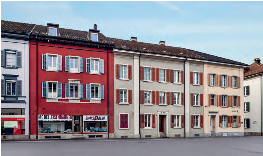
ABB. 50 Klingnau. Schattengasse 13–19. Die Häuser wurden nach dem Brand von 1883 nach detaillierten Vorschriften neu aufgebaut: Der Eingang und die Räume im Erdgeschoss mussten mindestens 30–45 cm über dem Trottoir liegen. Die Gesamthöhe des Gebäudes sollte inklusive Kniewand mit drei Geschossen 8,4–9 m betragen. Kreuzstöcke und Türgehäube sollten aus Stein gehauen werden. Für die Anlage der Trottoirs und der Pflasterung war die Gemeinde zuständig. Foto DPAG, Roger Wehrli, 2020.
