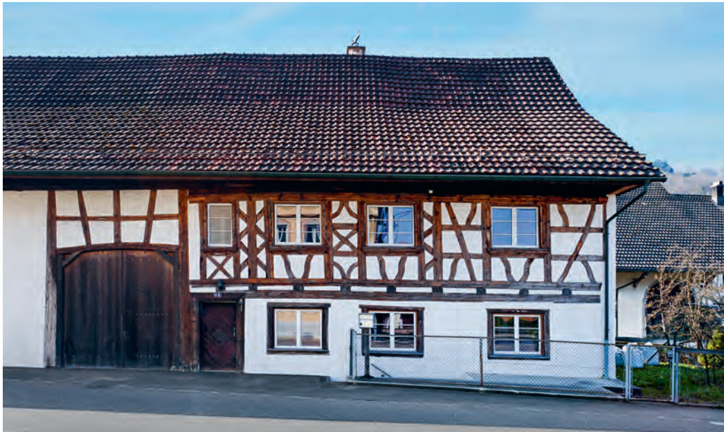
ABB. 346 Leibstadt. Leuggernstrasse 68. Bauernhaus. Das einzige Gebäude mit Sichtfachwerkfassaden gehört mit Baujahr 1714/15 auch zu den ältesten der Gemeinde. Die abwechslungsreich eingesetzten Kurzriegel an der Strassenseite dokumentieren den hohen Gestaltungsanspruch der unbekannteren Bauherrschaft. Foto DPAG, Roger Wehrli, 2022.
