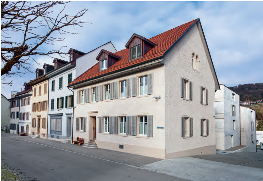
ABB. 49 Klingnau. Sonnengasse 18–22 (von rechts). Die Wohnhäuser entstanden nach dem Brand von 1875 erst 1883 und 1884. Die spätklassizistischen Bauten besitzen regelmäßig angeordnete Rechteckfenster und über niedrigem Sockel erhöhte, durch mehrere Stufen zugängliche Türen mit Gesimsbekrönung. Im Vordergrund rechts ist die anstelle von zwei Bauten nach dem Brand neu angelegte Querstrasse (Narregasse) sichtbar. Foto DPAG, Roger Wehrli, 2020.
