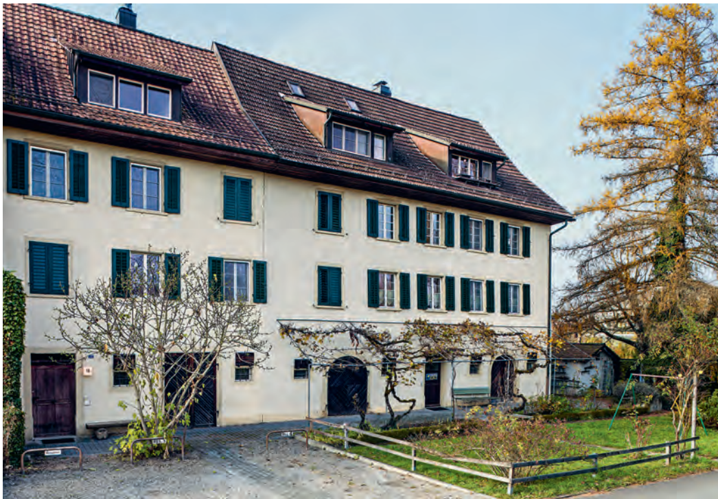
ABB. 196 Böttstein, Kleindöttingen. Dammweg 16, 18. Ehemaliges Fährhaus. Ansicht von Osten. Eine regelmässige Verteilung von Fenstern über drei bzw. fünf Achsen in den Obergeschossen und eine auf Symmetrie bedachte Abfolge von Hauseingängen und Stalltoren mit dazwischenliegenden kleindimensionierten Lüftungsfensterchen charakterisieren das flusseitige Erscheinungsbild. Foto DPAG, Roger Wehrli, 2021.
