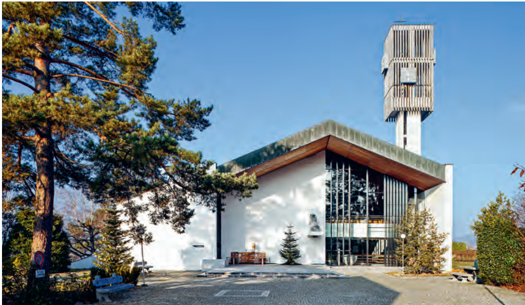
ABB. 206 Döttingen. Chilbert. Katholische Pfarrkirche St. Johannes Evangelist. 1960–61 von Hermann Baur. Ansicht von Südosten mit dem freistehenden Campanile im Hintergrund. Foto DPAG, Roger Wehrli, 2022.
