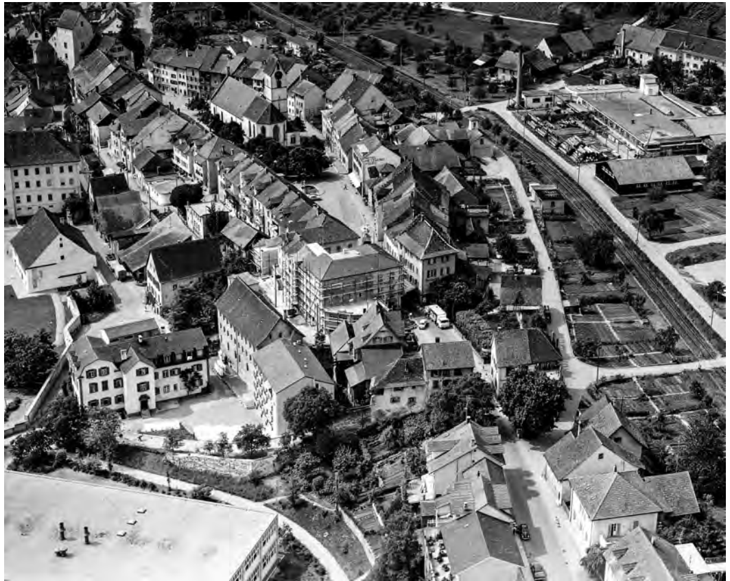
ABB. 127 Klingnau. Unterstadt. Luftaufnahme von Südosten. Links mit Mansardsatteldächern das ehemalige Schaffnerhaus der Johanniterkommende. Rechts davon, parallel zur Oberstadt, die einstige Johanniterkirche, die 1810/11 beim Ausbau als Schul- und Gemeindehaus ihr klassizistisches Äusseres erhielt. In der rechten Bildhälfte mittig die zwin-gerartige Situation des Obertors mit der stadtauswärts anschliessenden Weierstrasse. Foto Comet Photo AG, 1965. ETH-Bibliothek Zürich, Bildarchiv (Com_F64-02672 / CC BY-SA 4.0).
