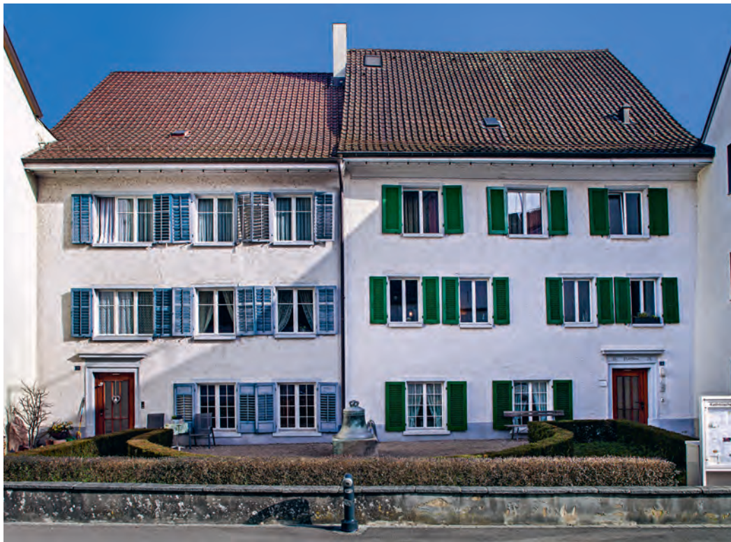
ABB. 91 Klingnau. Sonnengasse 28 und 30 (von rechts), Pfarrhaus und Kaplanei. Beide Gebäude gehen wohl ins Mittelalter zurück. Die Fassaden sind von Umbauten des späteren 19. Jh. und des 20. Jh. geprägt. Foto DPAG, Roger Wehrli, 2021.
