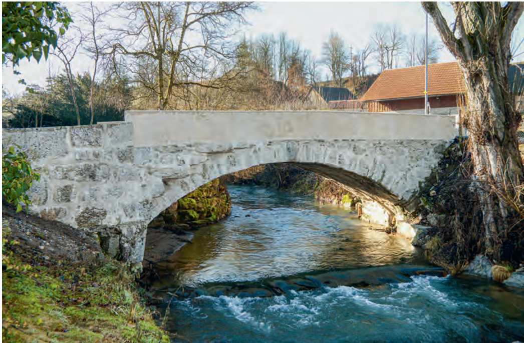
ABB. 286 Endingen, Unterendingen. Unterdorfstrasse. Die Surbbrücke von 1734 ist eine der ältesten Steinbogenbrücken des Kantons Aargau. Ihr flacher, weitgespannter Bogen lässt vermuten, dass sie von auswärtigen Bau-leuten errichtet wurde, die diese damals moderne Technik beherrschten. Foto DPAG, Roger Wehrli, 2024.
