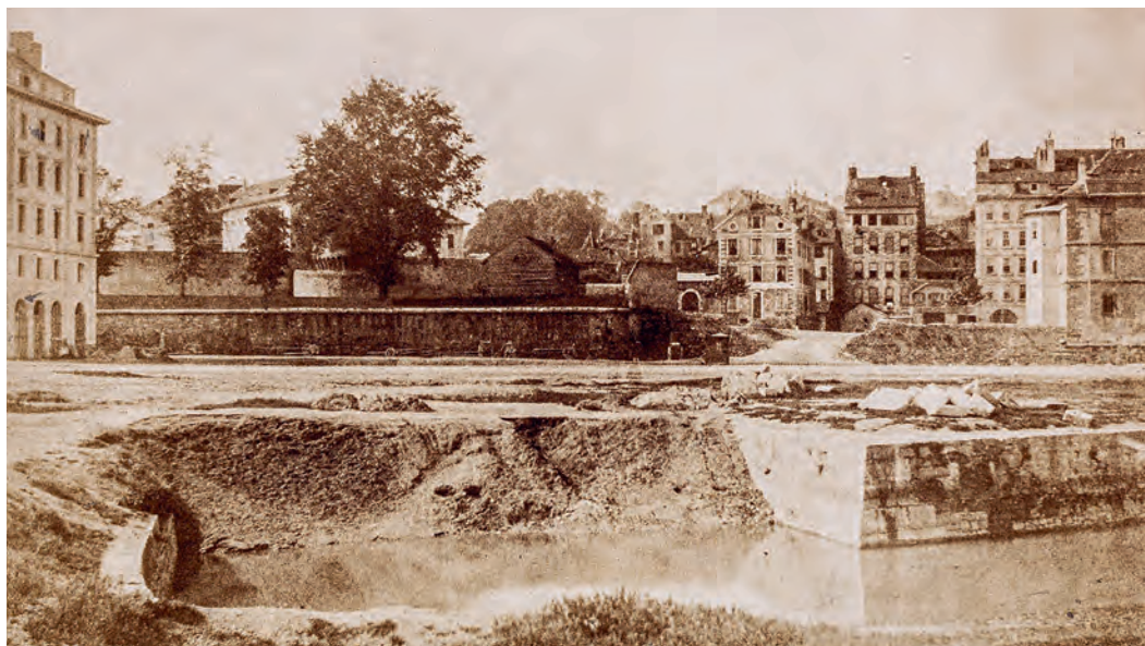
FIG. 14, 15 Photographie de Louis Populus montrant le chantier de démolition des fortifications de Rive vu depuis le nord, après 1852. Au-dessous, sa reproduction à la plume par Louis George (s.d.). Constituant une série de dessins à partir de photographies, le peintre détaille les légendes dans une optique documentaire. BGE [vg p 0639; vg 1241].
