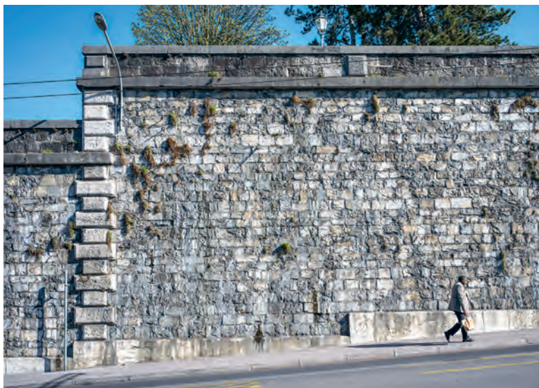
FIG. 45 Promenade de l'Observatoire, 1867-1870, surplombant le boulevard Émile-Jaques-Dalcroze. Les murs de soutènement sont constitués de pierre de Meillerie, un matériau courant à Genève dans les ouvrages de ce type, ainsi que dans les façades, les murs de refend et mitoyens des immeubles, où il est dissimulé sous un crépi. Photo Peter C. Taylor, 2024, IMAHGe.
