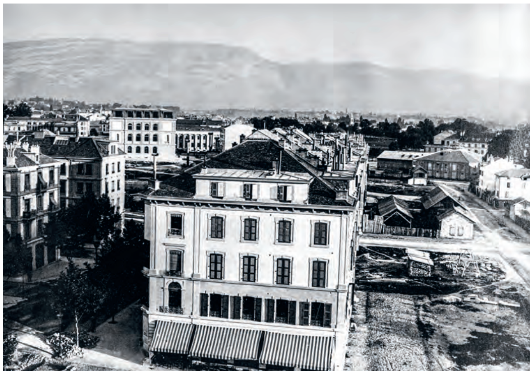
FIG. 64 Bd Georges-Favon, angle rue du Stand, vue du nord. Au premier plan, la façade du bâtiment de tête (n° 8), faisant partie d'une longue rangée d'immeubles construits à l'instigation de Benjamin Henneberg par les architectes André et Georges Matthey. Photo Atelier Boissonnas, sans date. BGE [FBB P GE 05-02 13].
