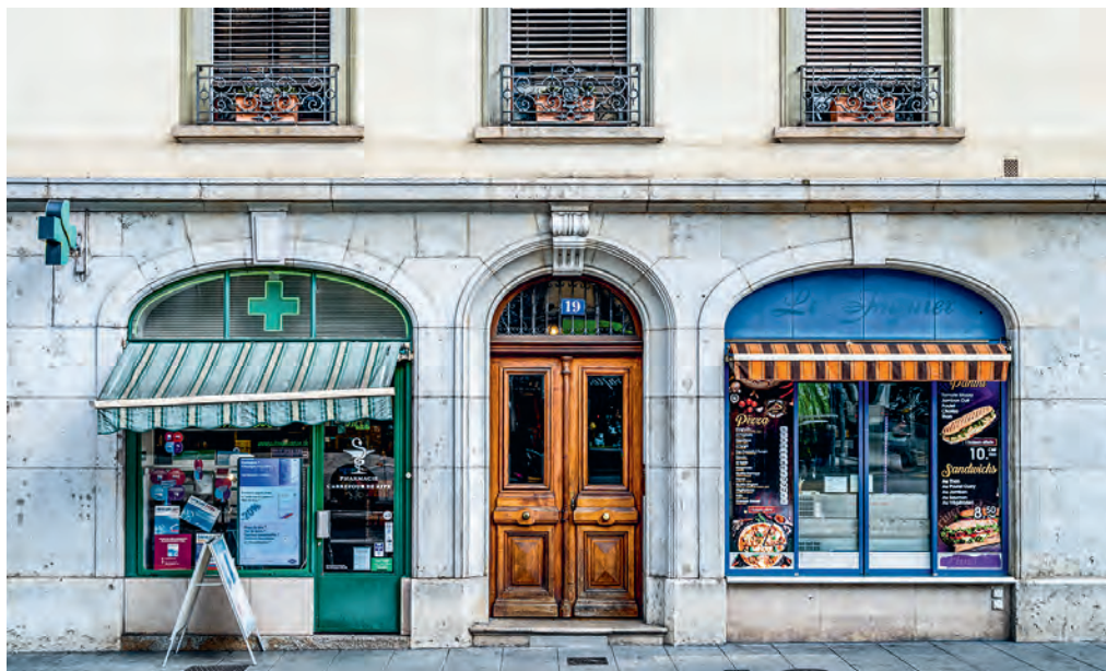
FIG. 428 Cours de Rive 19. Henri Vaucher, architecte, 1874-75. Arcade de l'immeuble marquée par un encadrement en faible relief et une clé très sobre. L'appareil des pierres formant les piédroits et les claveaux est clairement visible. Photo Peter C. Taylor, 2024, IMAHGe.
