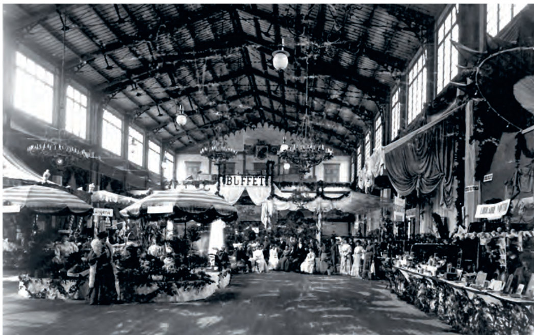
FIG. 189 Rue du Général-Dufour 24. Intérieur du palais électoral. Lieu de foires et de bazars temporaires, la halle forme un vaste espace totalement libre, permettant une multitude d'usages. L'éclairage nocturne est assuré par des lustres impressionnants et des suspensions en verre. Photo vers 1890. BGE [vg n13x18 13171].
