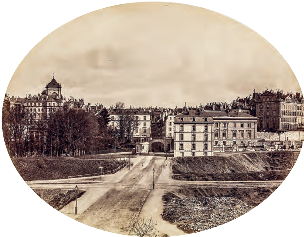
FIG. 150 Vue vers le nord de la rue de Saint-Léger fraîchement nivelée et dotée de candélabres, mars 1866. Là comme ailleurs, l'éclairage urbain précède la construction des nouveaux quartiers. Il n'est pas inutile pour autant, puisqu'il borde une voie de circulation reliant la ville ancienne au faubourg de Plainpalais. Photo anonyme. BGE [phot25p st le 04].
