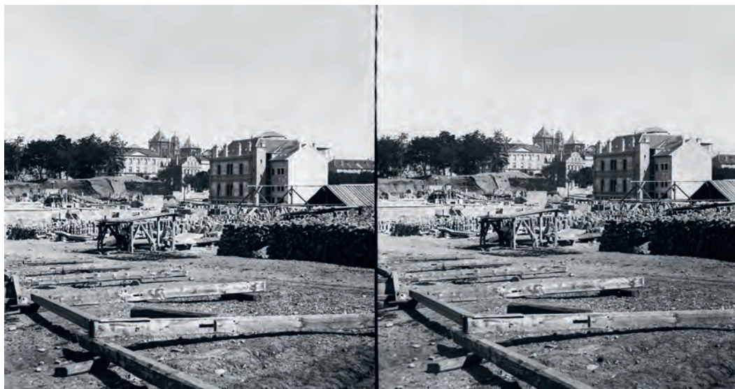
FIG. 467 Terrasse de Saint-Victor 2. Hôtel particulier, par César Auguste Pompée, 1861-62. La vue montre la face donnant sur l'actuelle rue Charles-Bonnet et celle, en attente, de l'arrière-corps. Le bâtiment tourne sa face principale en direction de la ville ancienne, cherchant le vis-à-vis avec les beaux bâtiments de la promenade de Saint-Antoine. Photo vers 1862. BGE [vg n13x18 15058].
