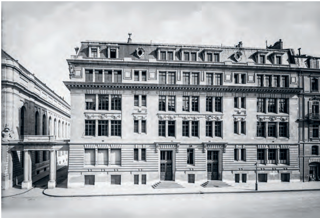
FIG. 241 Bd Émile-Jaques-Dalcroze 11. Façade sur rue de l'École des Casemates. Léon et Frantz Fulpius, architectes, 1901-02. La façade en pierre de taille aligne des baies jumelées et en triplets, adaptées aux locaux qu'elles éclairent. S'agissant d'une école primaire pour garçons, la double entrée marque ici la volonté de séparer les grands des petits. Photo Frank-Henri Jullien avril 1914. BGE [vg n18x24 03856].
