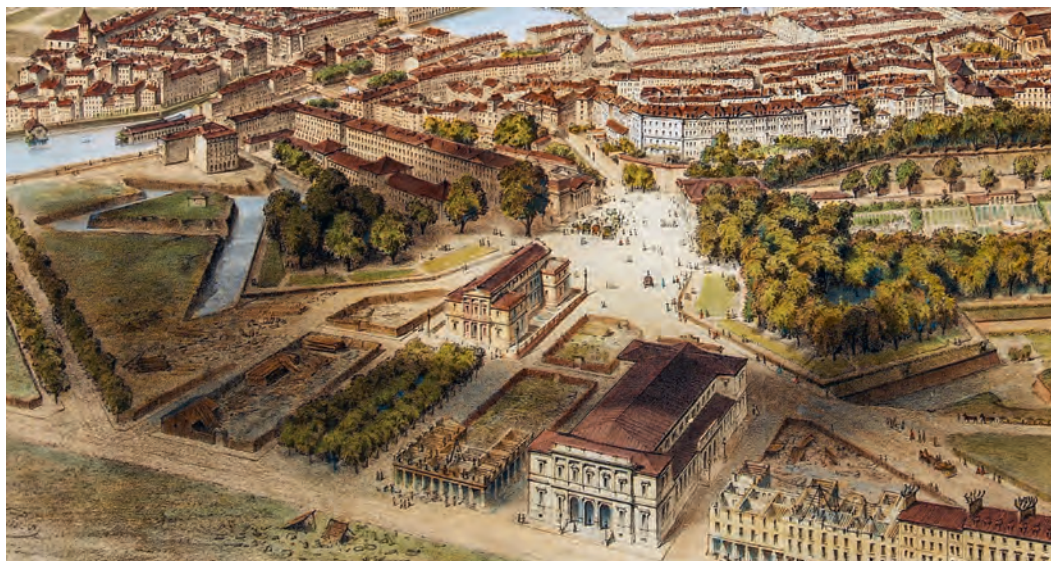
FIG. 80 Alfred Guesdon, Genève, détail de la vue cavalière de la ville prise au-dessus du bâtiment électoral, 1858. Les bâtiments nouvellement édifiés voisinent avec des chantiers de construction, des parcelles ceinturées de palissades, des terrains vagues. BGE [17M 04].
