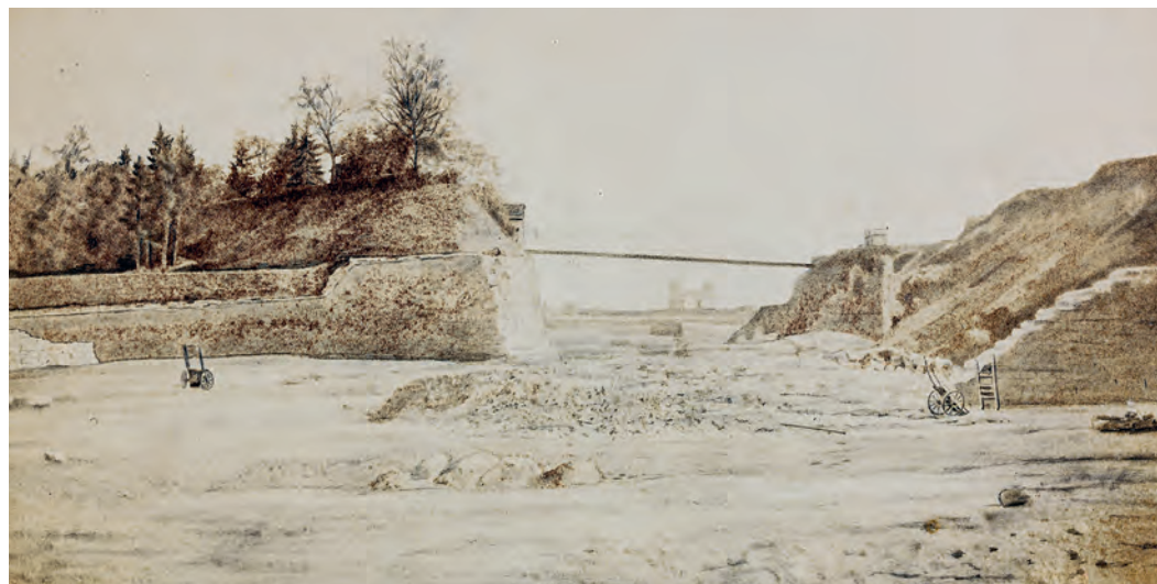
FIG. 7 Les travaux de démolition qui ont lieu vers 1855 autour du bastion du Pin participent du nivellement généralisé auquel sont soumises les anciennes fortifications. Photo retouchée à l'aquarelle et à la mine de plomb attribuée à Alexandre-Louis-François d'Albert-Durade, vers 1855. BGE [Phot25P Pin 06].
