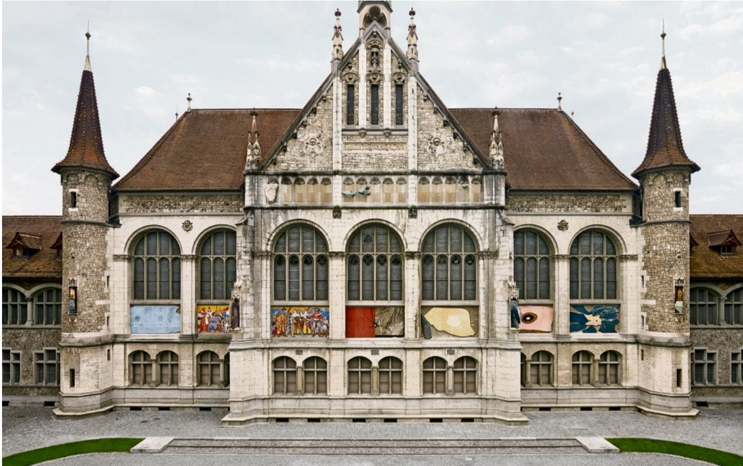
Mario Salas Siegerprojekt, als gehörte es schon immer an die Fassade, hinter der die Ruhmeshalle mit Hodlers Marignano-Fresken liegt. zvg / Studio Willen
